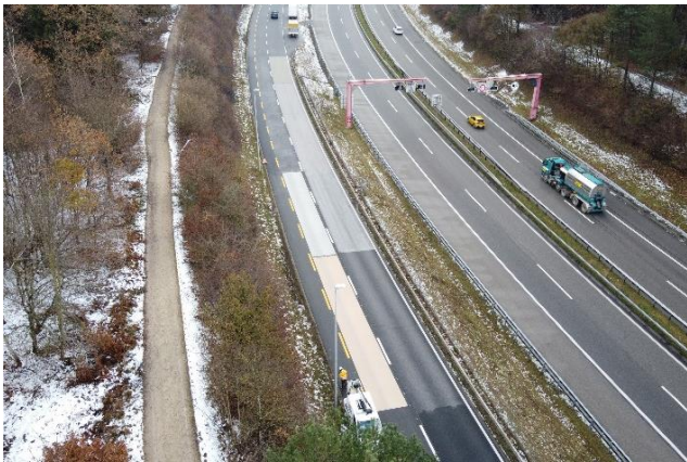
Abbildung 49 Verschiedene Strassenbeläge auf einer Teststrecke in Bern © Grolimund + Partner AG
