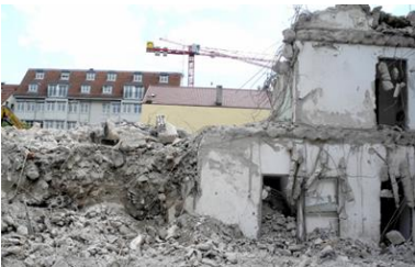
Abb. 3 Innenstädtische Rückbaumassnahme © Stadt Karlsruhe, Stadtplanungsamt
