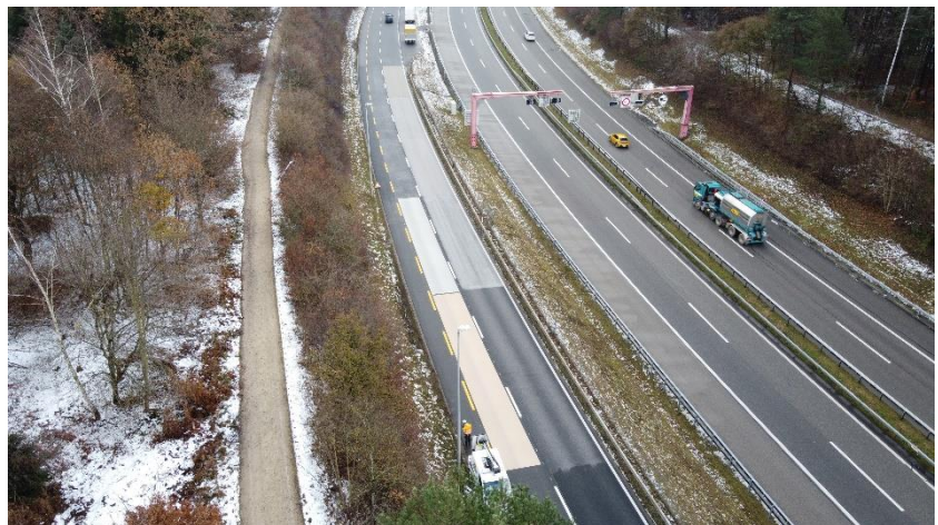
Abb. 2 Im Projekt «Kühle Strassenbeläge» werden verschiedene Asphaltmischungen in Bern getestet © Grolimund + Partner AG
