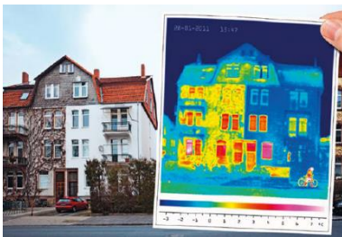
Abb. 1 Wärmeabstrahlung einer sanierten (rechts) und nicht sanierten Fassade (BAFU, 2018)
