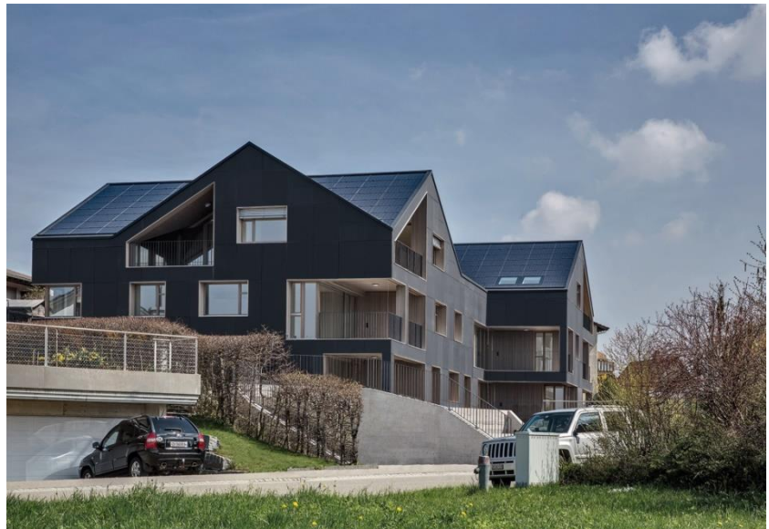
Abb. 2 Erstes energieautarkes Mehrfamilienhaus der Welt, ein Projekt der Umweltarena Schweiz © Umweltarena
