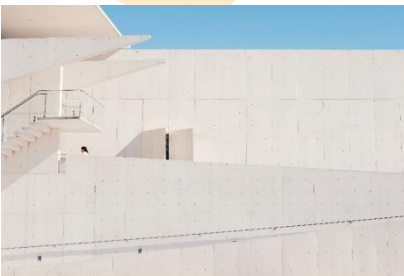
Abb. 10 Eine weisse Gebäudewand erhöht die Reflexion und vermindert somit die Hitzaufnahme © Pixabay
