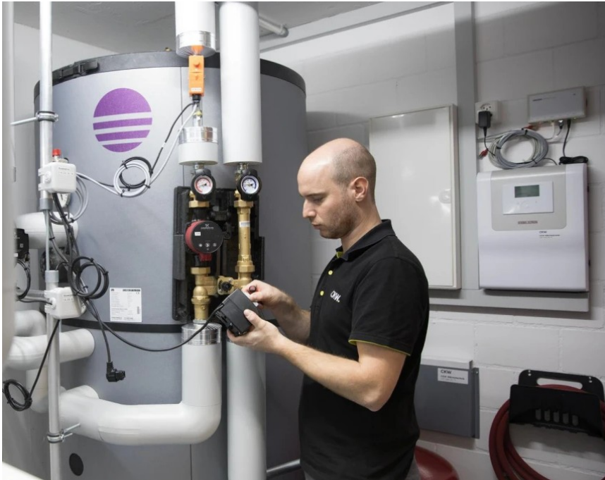
Installationsarbeiten am Heizsystem: Quelle CKW
